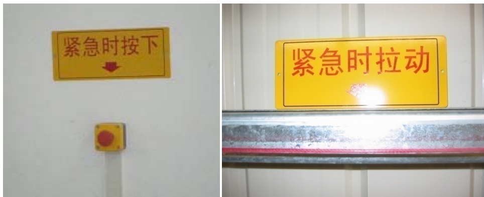
图10-8急停按钮、急停拉线
